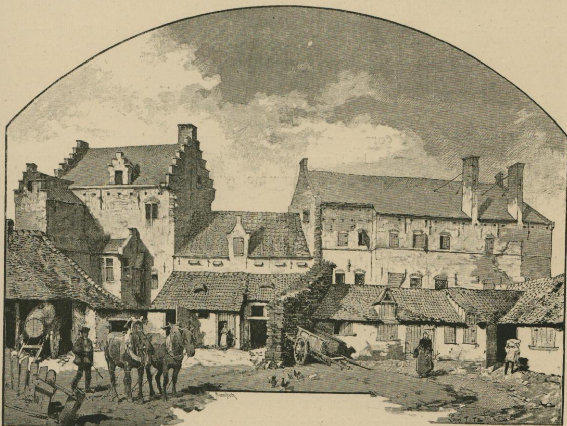
LES RUINES DU REFUGE D'AFFLIGHEM A ANVERS.
